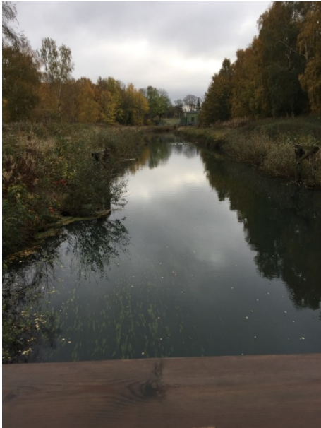
Figur 30. Stordiket uppströms pumpstationen vid Hammarsjön.
