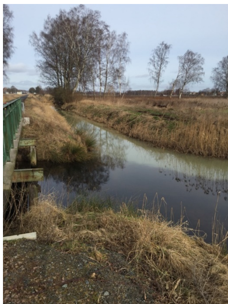
Figur 35. Reningsverksdiket (H3) (från vänster på bilden) där detta rinner ut i Stordiket strax nedströms H2.
